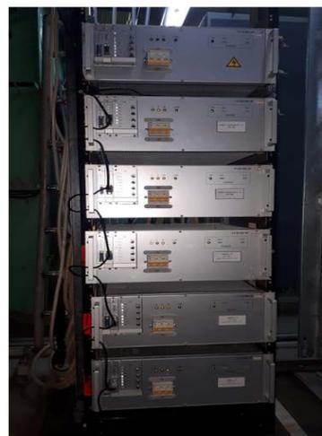
Рис.5.4.3. Стойка замененных источников ВЧ-500 и ВЧ-1000 (слева) и ВЧ-1300 и ВЧ-1000 (справа).
