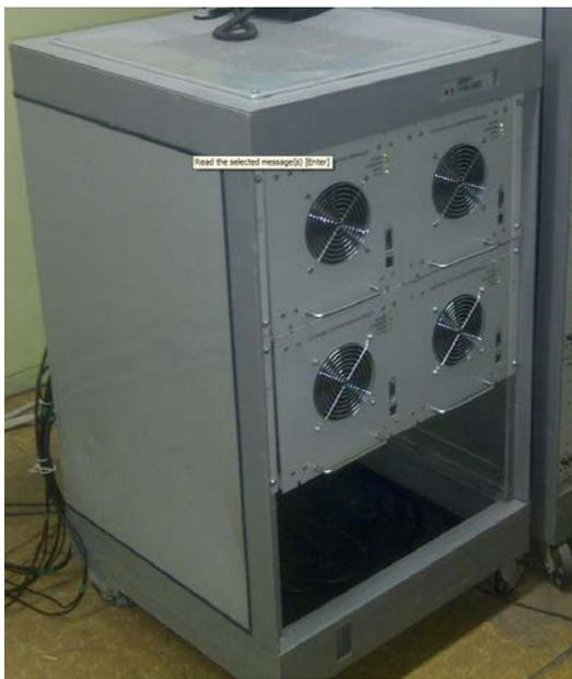
Рис. 10. 2.1. Стойка с новыми ИП электростатики в комнате источников питания.
