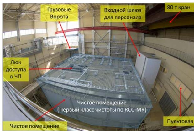
Рис. 4.5.4. Фотография чистого помещения в здании 20 для создания условий согласно RCC-MR.
