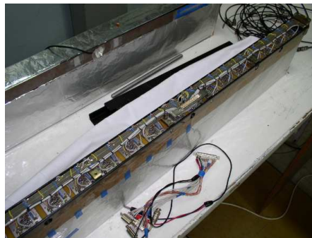
Рис. 15. Модуль после электрического монтажа.
