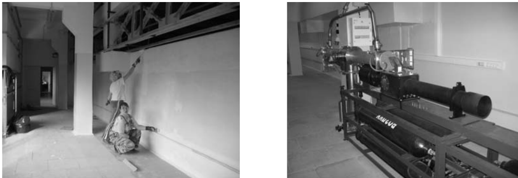
Рис. 24: Этапы строительства установки для исследования влияния терагерцового излучения на газовые потоки путем оптического зондирования в видимом диапазоне.
