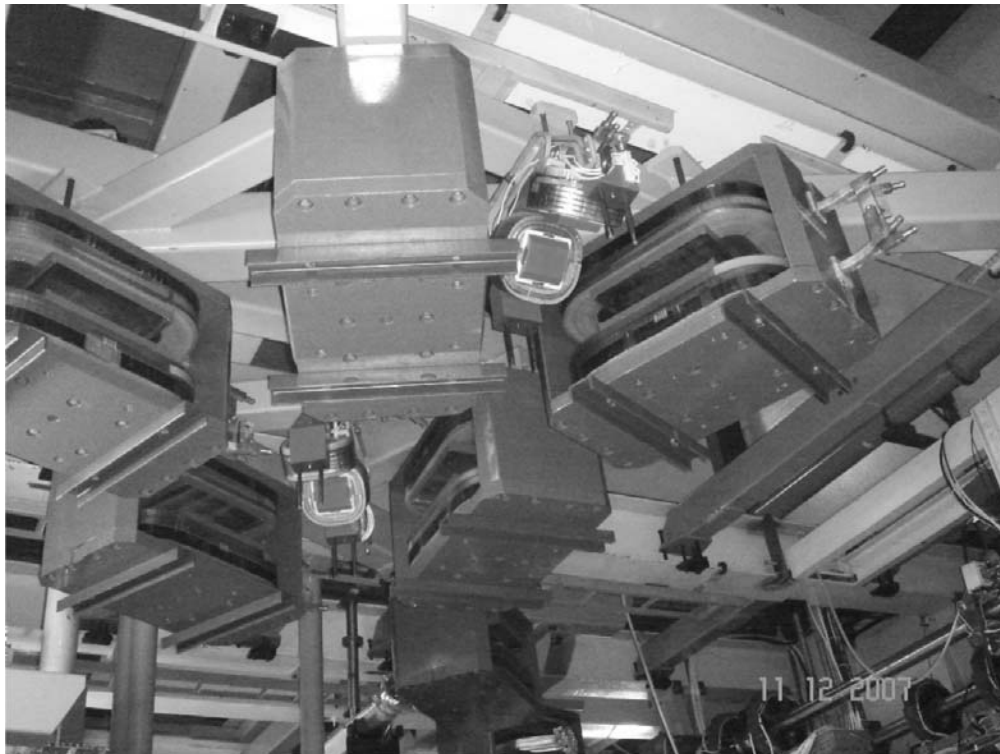
Рис. 26: Поворотные магниты и верхние половины квадрупольных линз перед установкой вакуумных камер.
