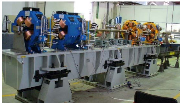
Рис. 3: Первая установка прототипов магнитов на прототип гирдера в CELLS (Барселона)
