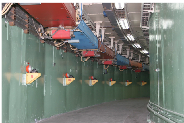
Рис. 1.4. Тоннель ВЭПП-4М вблизи вигглера.
