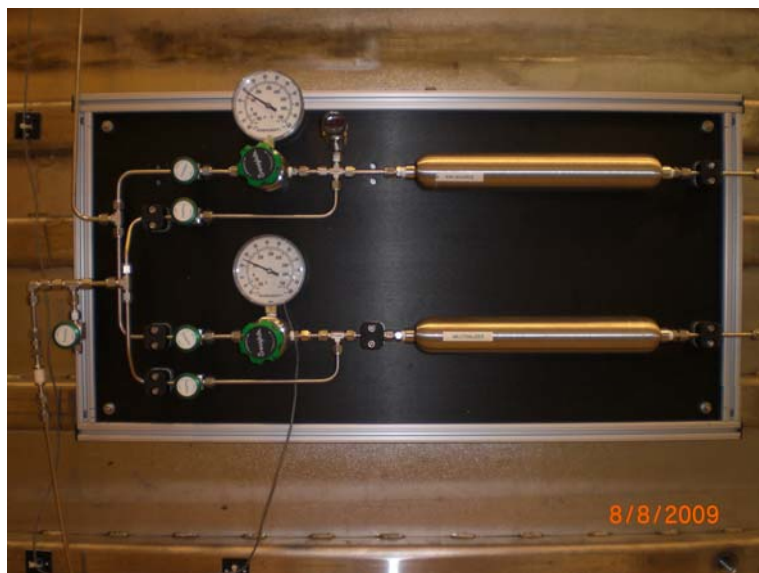
Часть газовой системы нейтрального инжектора (Swagelok)
