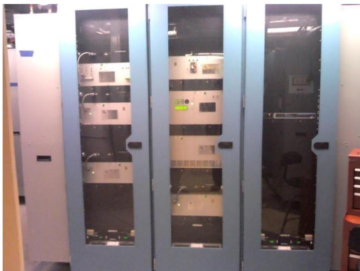
Рисунок 6.10. Трехканальная система питания квадрупольных магнитов бустера NSLS-II.
